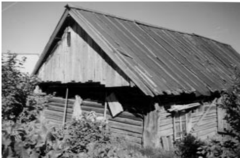
Рис. 18. Помещение для скота. Пазовая техника возведения стен, д.Вязовка. 1997 г.
