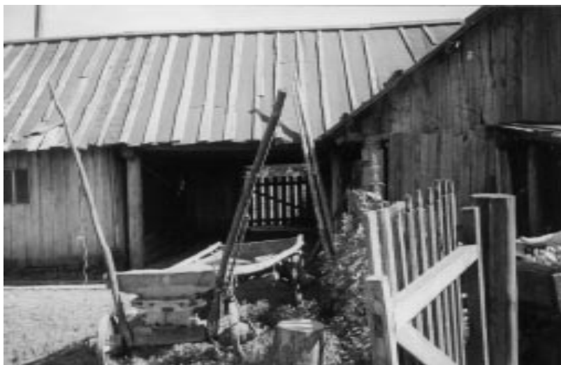
Рис. 23. Соединение помещений для скота навесом, д.Вязовка. 1997 г.
