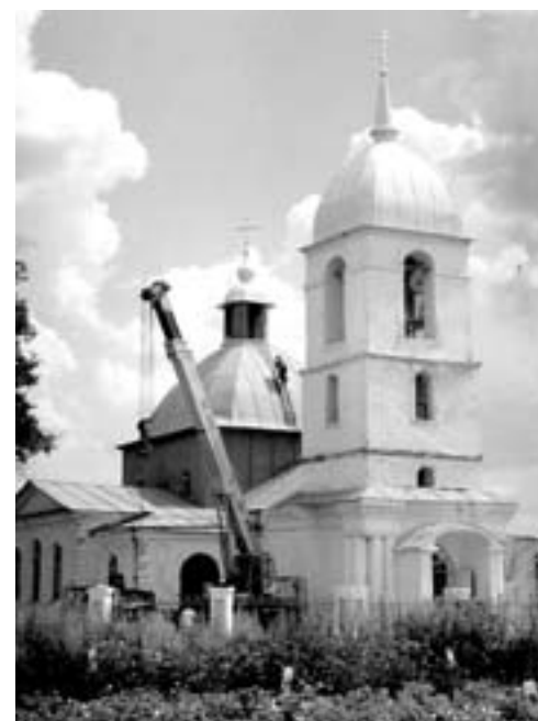
Установка маковки купола. 11 июля 2006 г.
