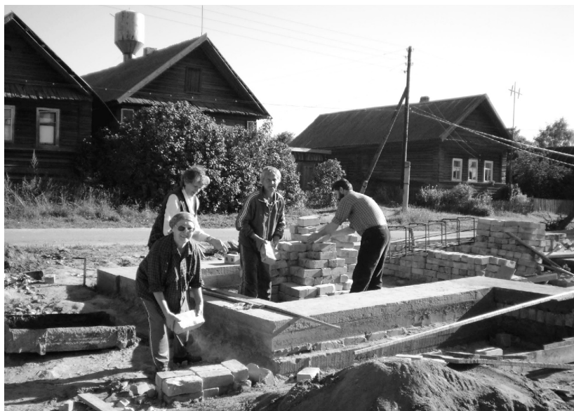
У фундамента строящейся часовни в Бирючёве. Фото 2007 г.
