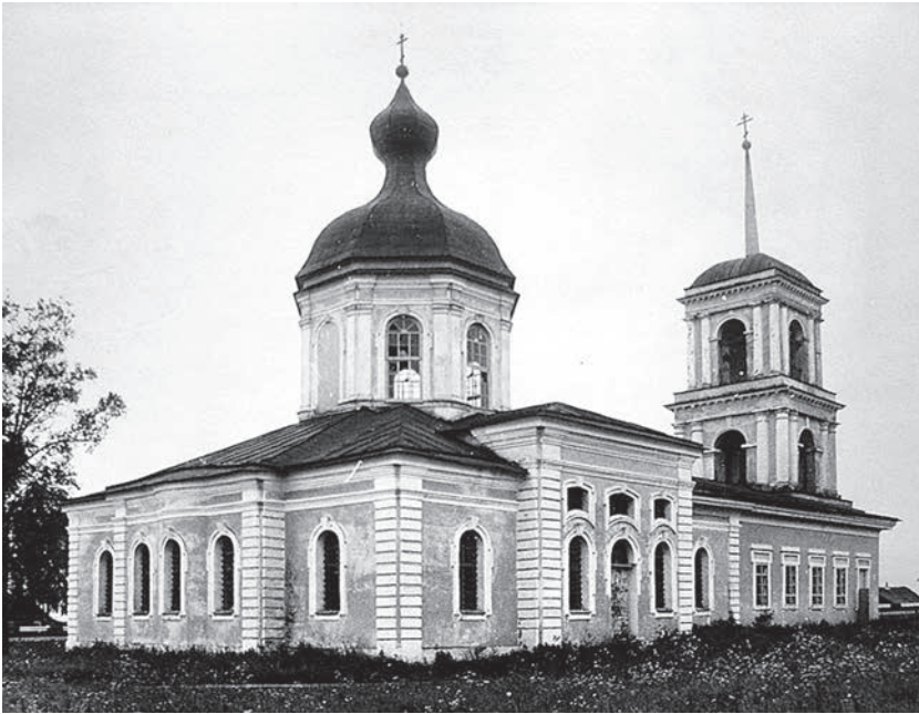
Храм Михаила Архангела в Хотилове, построенный по проекту С.И. Чевакинского, помогает представить, как выглядело внешнее убранство выдропужской церкви до ремонта 1840 г.
