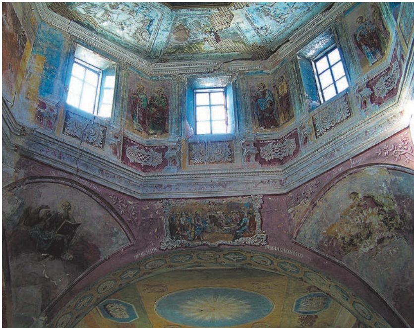
Общий вид купола летнего храма до начала реставрации. 2008 г.
