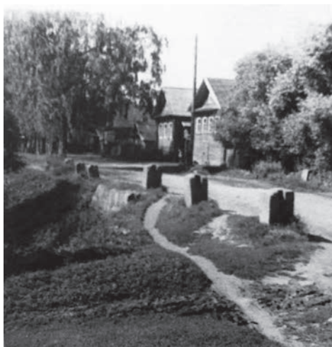
Каменный мост по дороге к храму. Фото 1950-х гг.
