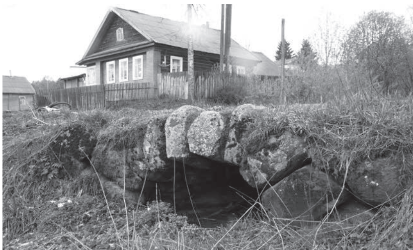
Каменный мост над устьем Георгиевского родника. Здесь проходила старая дорога по берегу Тверцы из Москвы в Новгород
