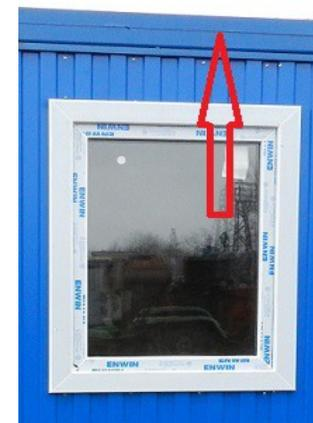
5. Производится герметизация вставных элементов (окон, дверей, кондиционеров и т.д.) путем обработки проемов монтажной пеной, что исключает продувание блок-контейнера.
