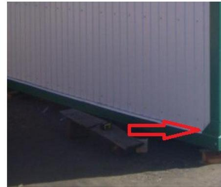
3. Отлив выполненный из гладкого оцинкованного листа с завальцованными краями в первую очередь служит водоотводом, при его правильном монтаже не допускает попадание влаги на деревянную обрешетку, что исключает сырость в блок-контейнере, а также увеличивает его срок службы.
