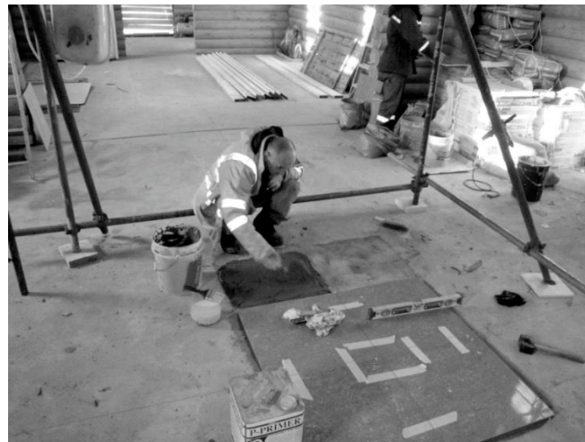
Укладка керамогранитной плитки на пол Храма
