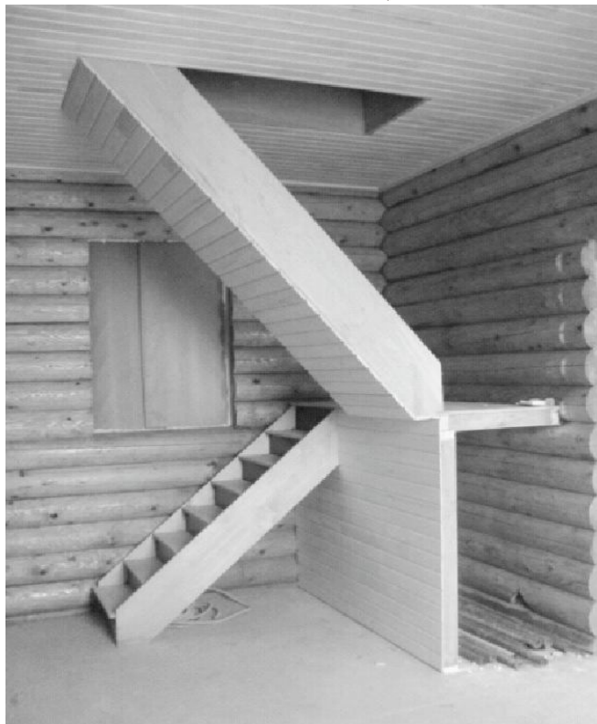
Покраска стен Храма изнутри Внутренняя отделка
