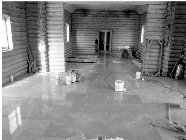
Укладка керамогранитной плитки на пол Храма
