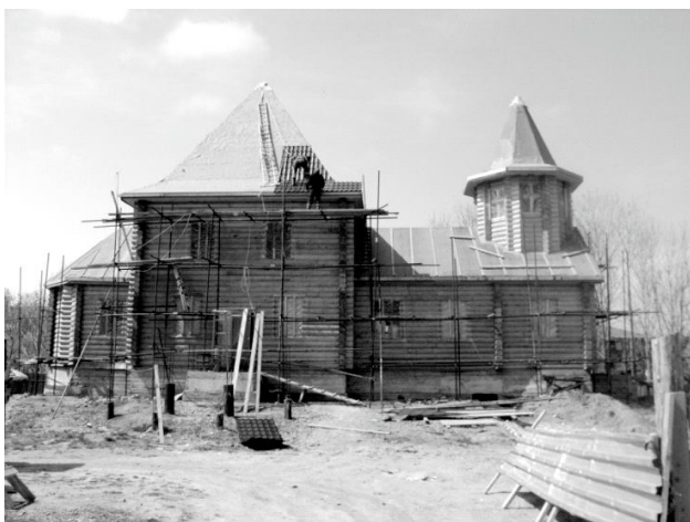
Покрытие кровли металлочерепицей
