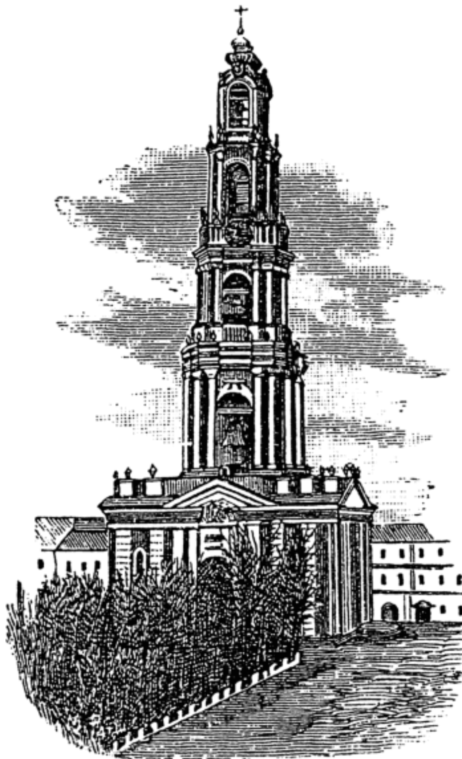
Вид колокольни в лавре
